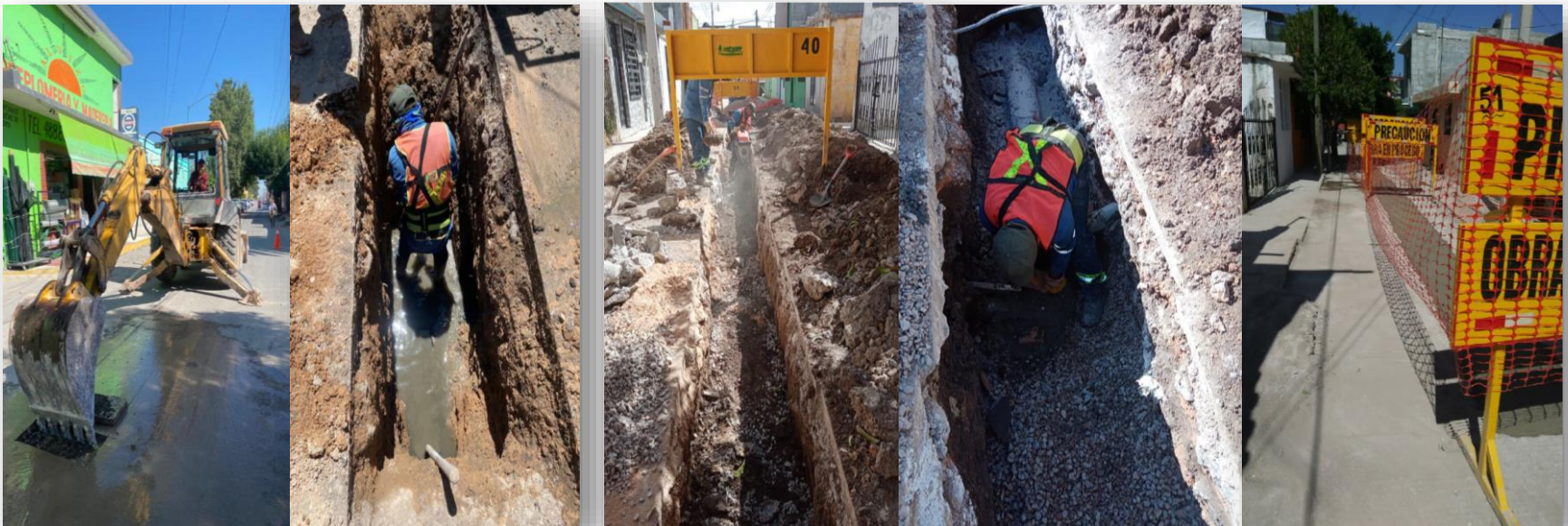
Calle Juárez casi esq. Filomeno Mata, se rehabilitan 2 ml tubo PVC sanitario de 10"
