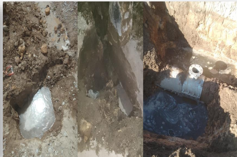
Reparación de fuga en línea de conducción de A/C tramo El Solano cambiando abrazadera de acero inoxidable de 16" x 8"
