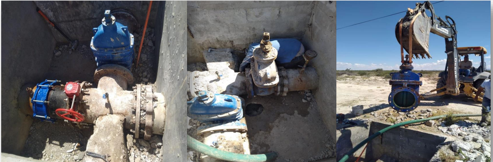
Cambio de válvula en la derivación (Acueducto Cedral – Matehuala)
