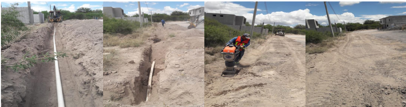
Ampliación de la red de agua potable en calle Pinabete, colonia La Florida, 36 ml con tubo de 2"
