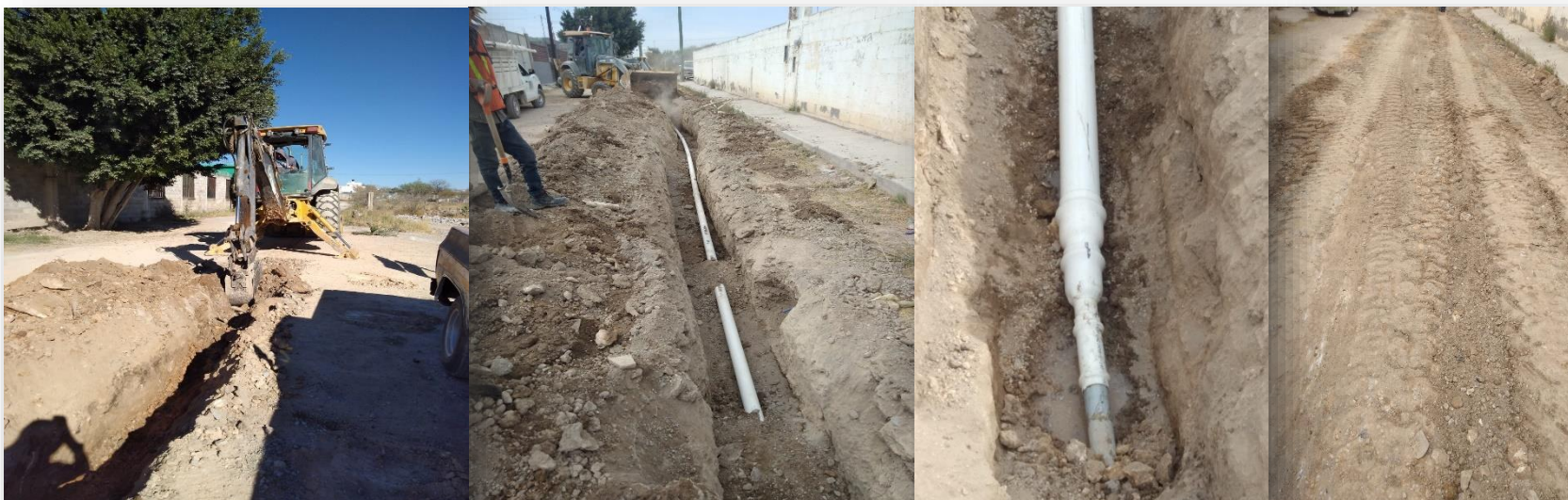
Cambio de tubería en calle Valles , col. Manuel Moreno Torres, 210 ml de 1.5 a 3"
