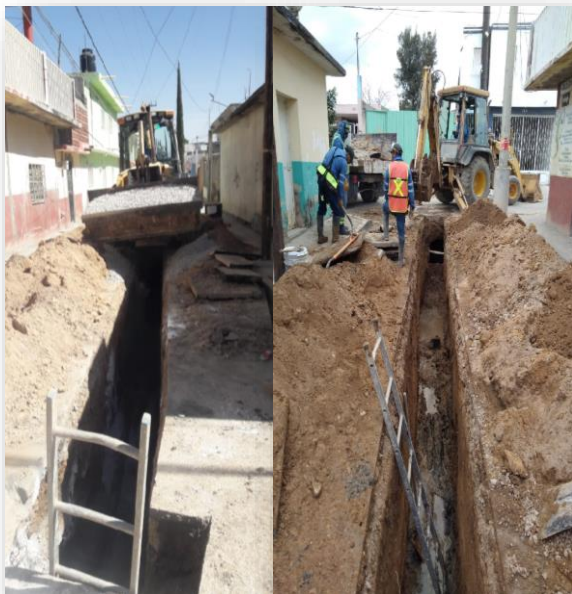
Calle Lázaro Cárdenas con Aquiles Cerdán, 14 mts pvc sanitario de 10"
