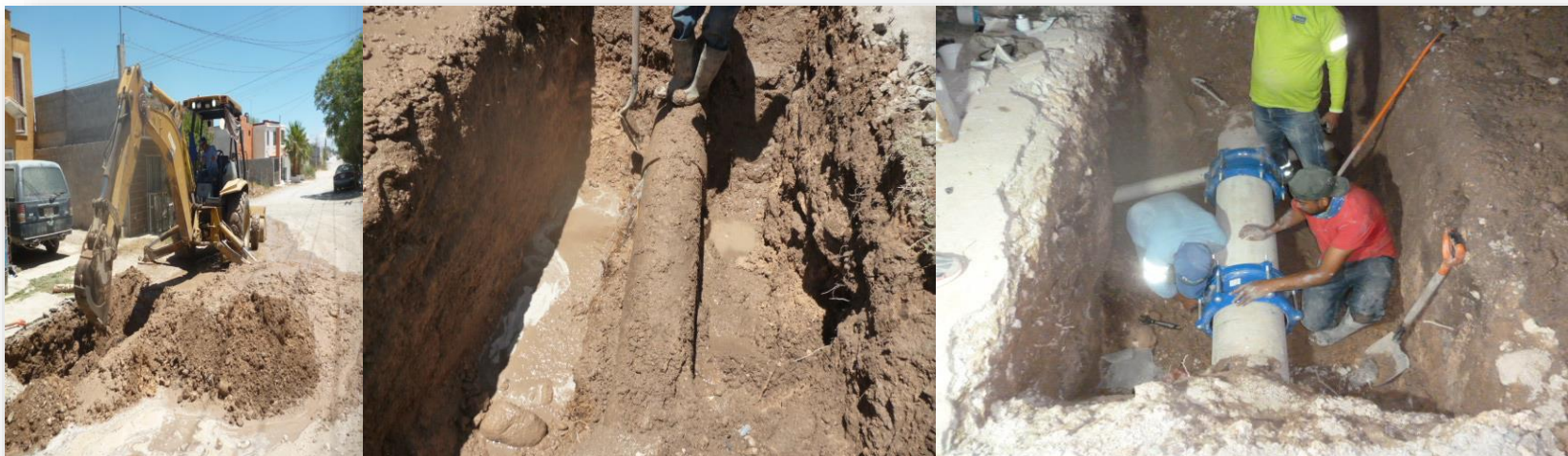
Reparación de fuga en red general en tubo A/C de 12" en Manuel Esperón casi esq. Zeferino Ponce.
