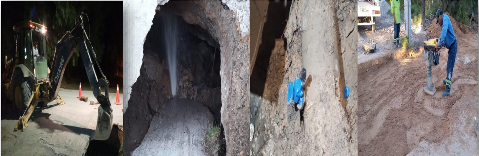
Reparación de fuga en red general Prol. Hidalgo esq. Pinos.
