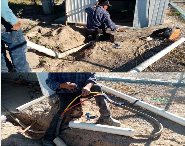
Cambio de transformador de 75 kva para pozo 20
