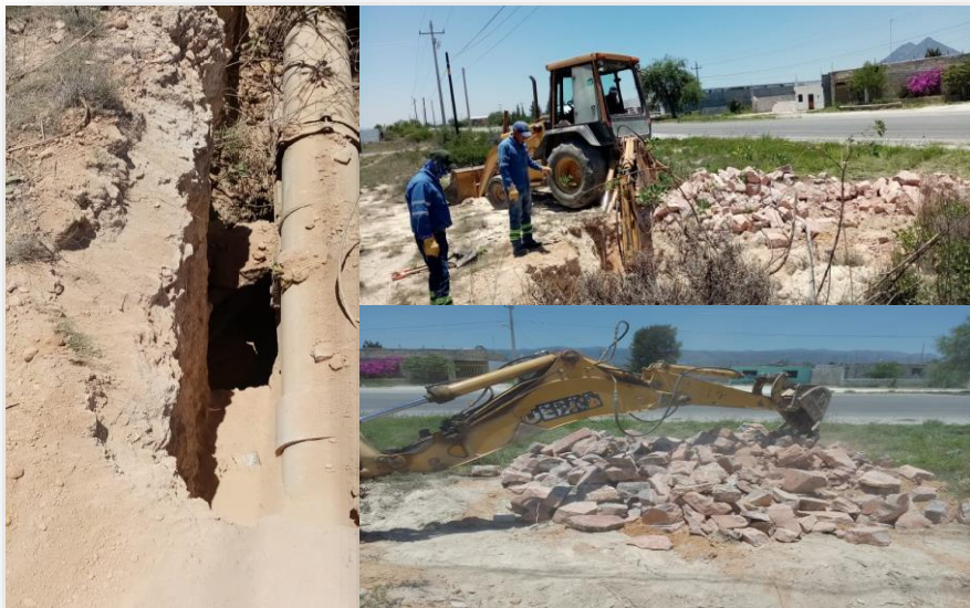
Reparación de fuga en sitio conocido como el Hawái en acueducto Cedral Matehuala, relleno de zanja con 18 mts piedra rostro y 6 mts. tepetate
