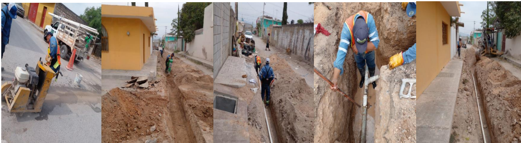
Ampliación de la red de agua potable en calle Díaz Ordaz con Manuel Acuña, 42 ml con tubo de 2"
