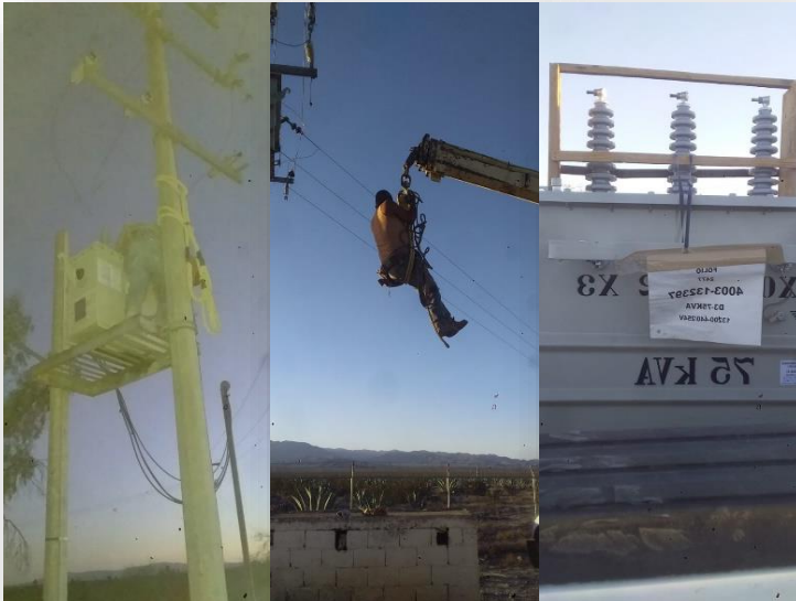
Cambio de transformador de 75 kva para pozo 20
