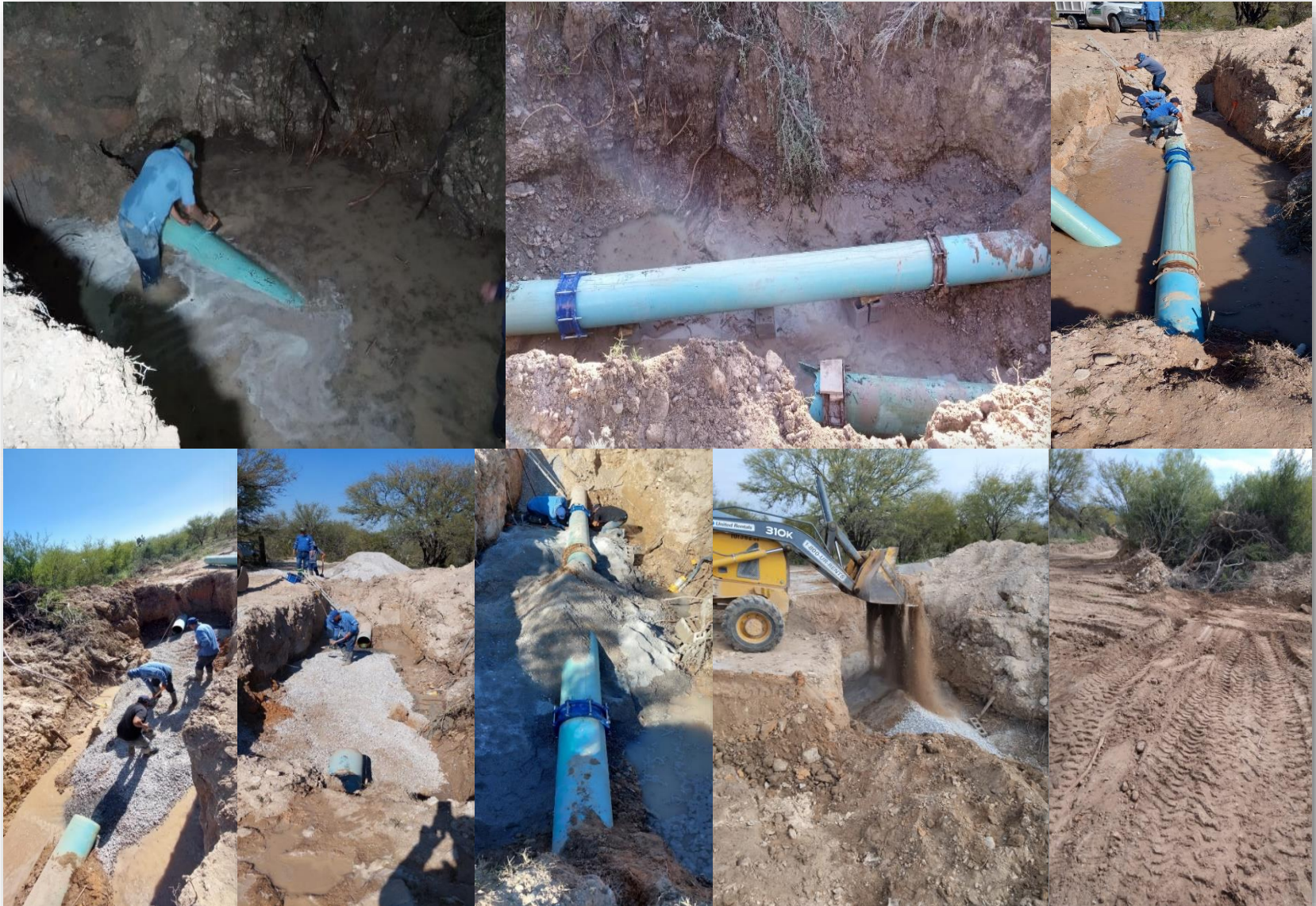
Reparación de fuga en ducto poniente (Ejido La Cabra).
