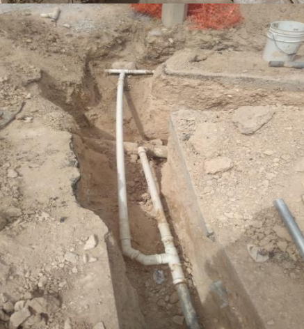
Conexión de tee de 4" a 3"
