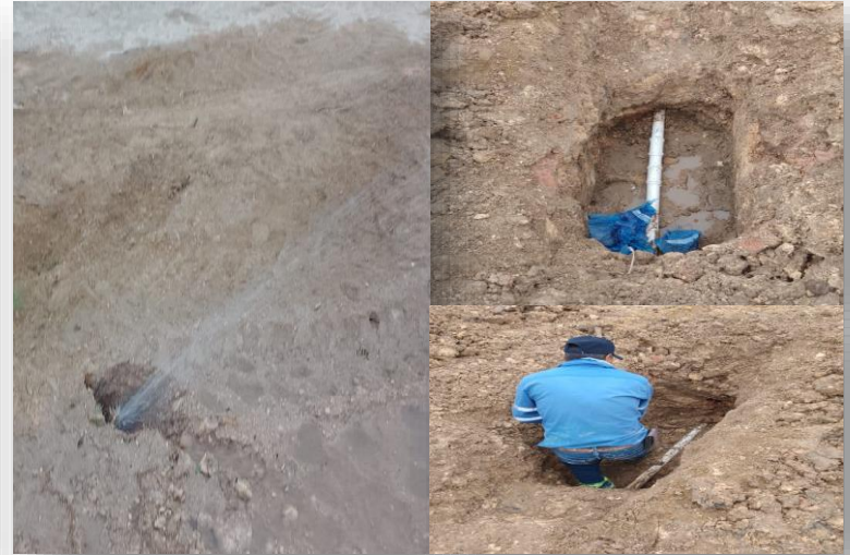
Reparación de fuga en línea de conducción, Pozo 19
