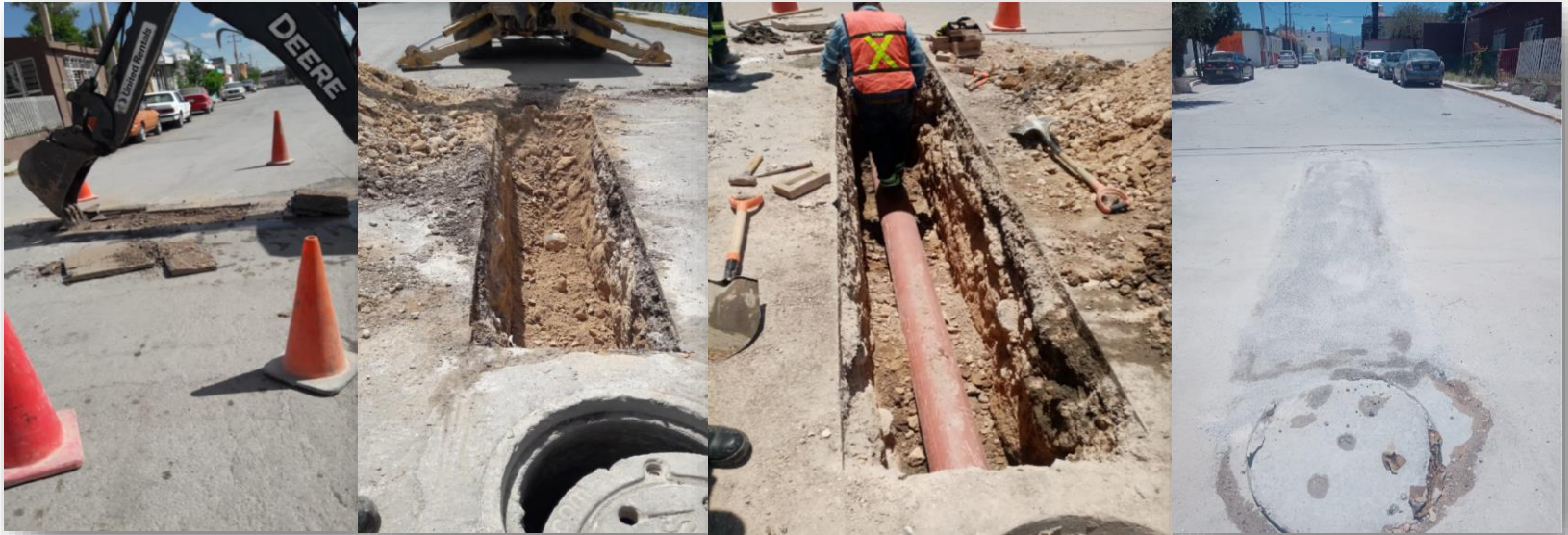
Interconexión de pozo a pozo de visita, instalando 6 mts tubo pvc sanitario de 10", calle Mexicana de Aviación 409
