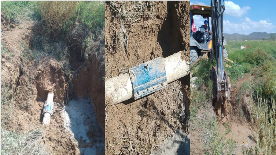
Reparación de fuga en Pozo Santa Martha
