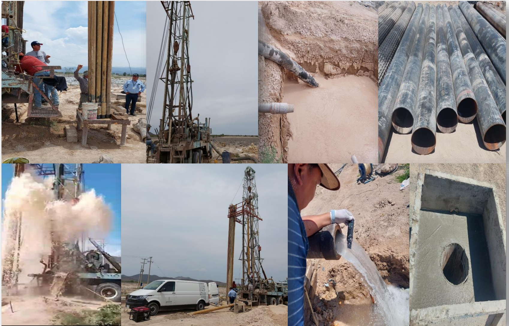
Perforación del pozo profundo para agua potable en el Rancho Santa Martha, Municipio de Cedral, S.L.P. (250 mts de profundidad), contrato SAPSAM-PRODDER-IO83-G67-824020999-N-01-2023
