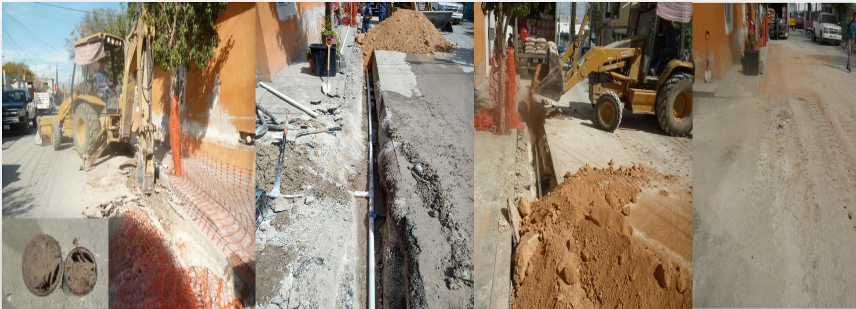
Rehabilitación de la red de agua, 18 ml en tubería de 2", en calle Coahuila esq. Irapuato
