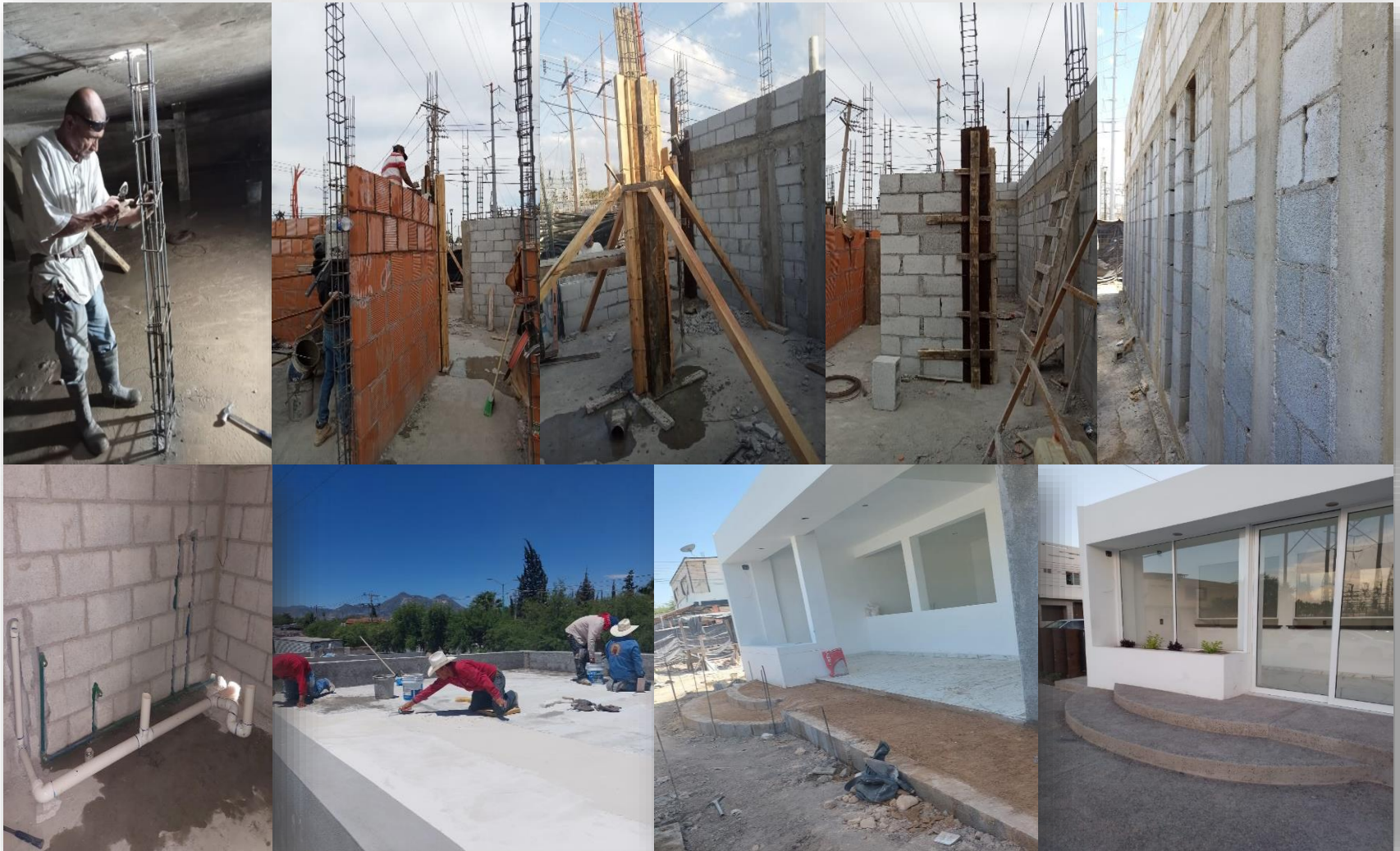
Construcción de espacio para cultura del agua ubicado en Juárez, col. Colinas de La Paz, contrato SAPSAM-AD-OB-002-2023
