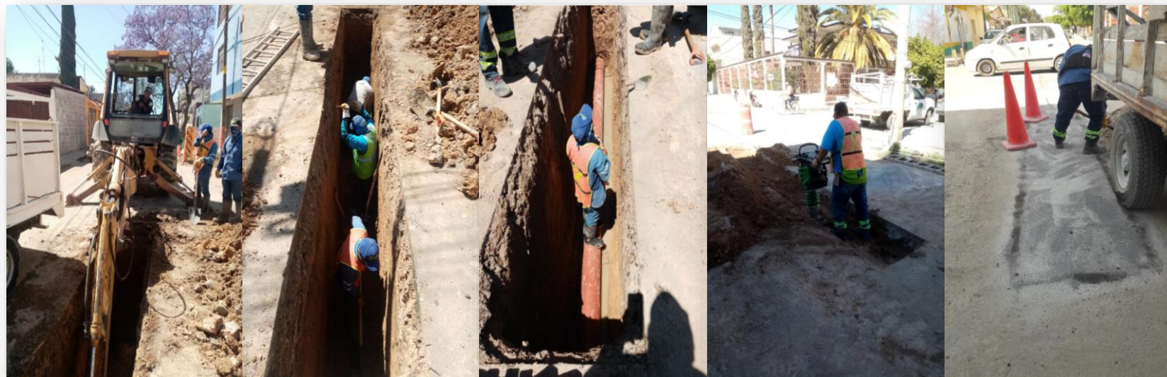
Calle 16 de Septiembre con Mariano Vázquez, 6 mts pvc sanitario de 10"
