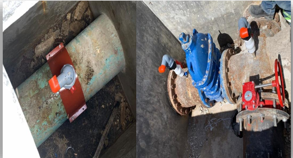
Instalación de válvulas expulsoras de aire
