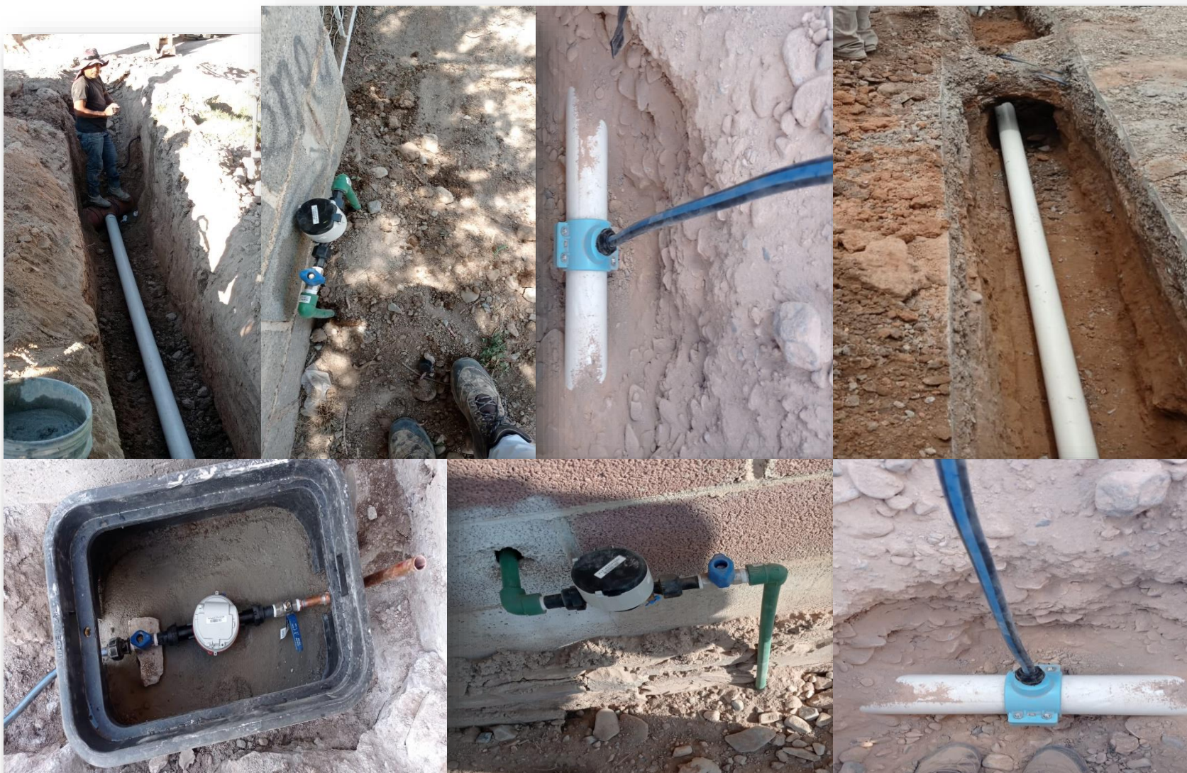
Instalación de tomas de agua potable e instalación de descargas de agua residual, contrato SAPSAM-AD-OB-001-2023
