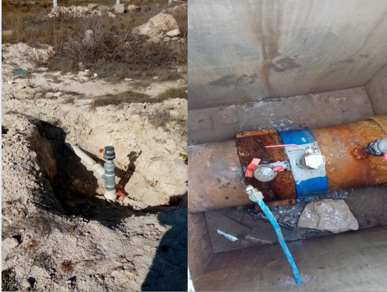
Instalación y reposición de desfogues
