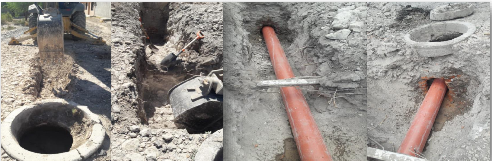
Interconexión de pozo a pozo de visita, instalando 6 mts tubo pvc sanitario de 10", calle Mexicana de Aviación 409
