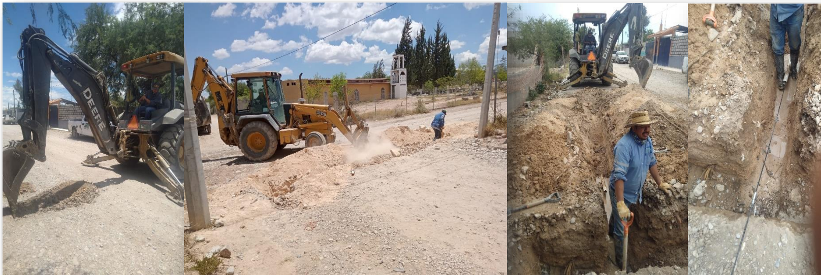
Sondeo en Santa Ana de abajo derivado de bajas presiones (Búsqueda de tapones)
