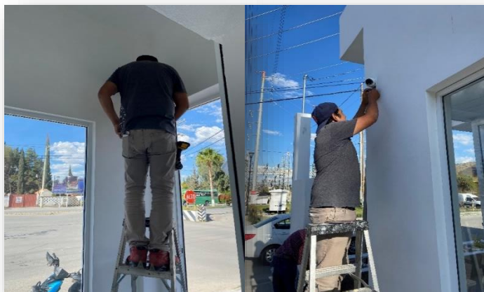
Supervisión a instalación de cámaras de seguridad
