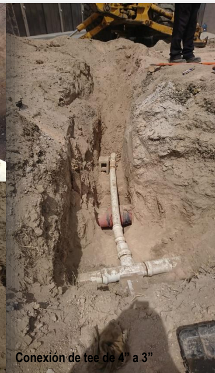
Conexión de tee de 4" a 3"
