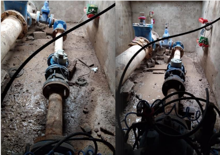
Nivelación de tren hco. M-41
