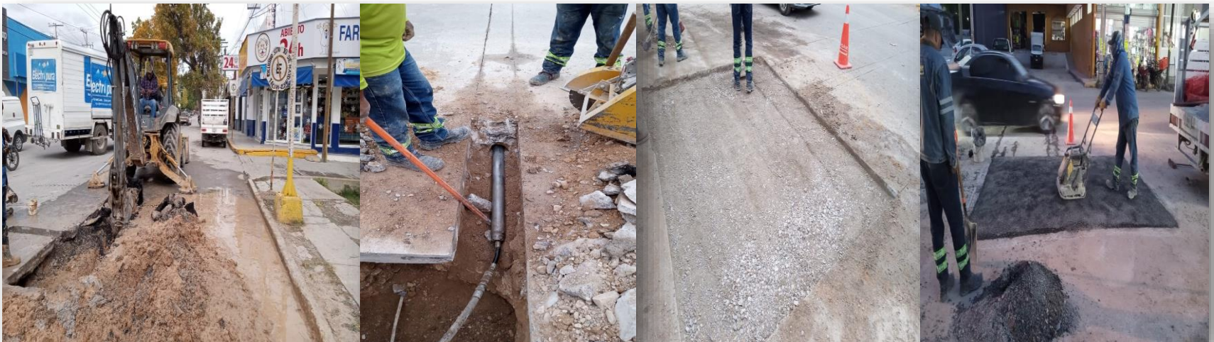
Cambio de toma por fin de vida y reposición de pavimento
