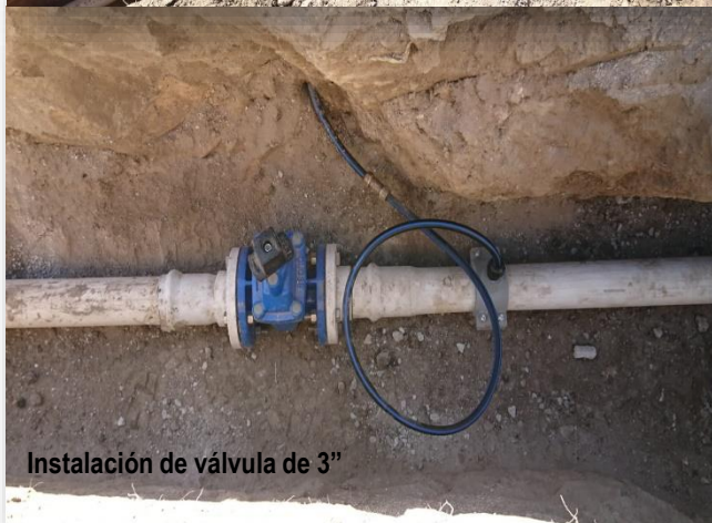
Tendido de tubería
