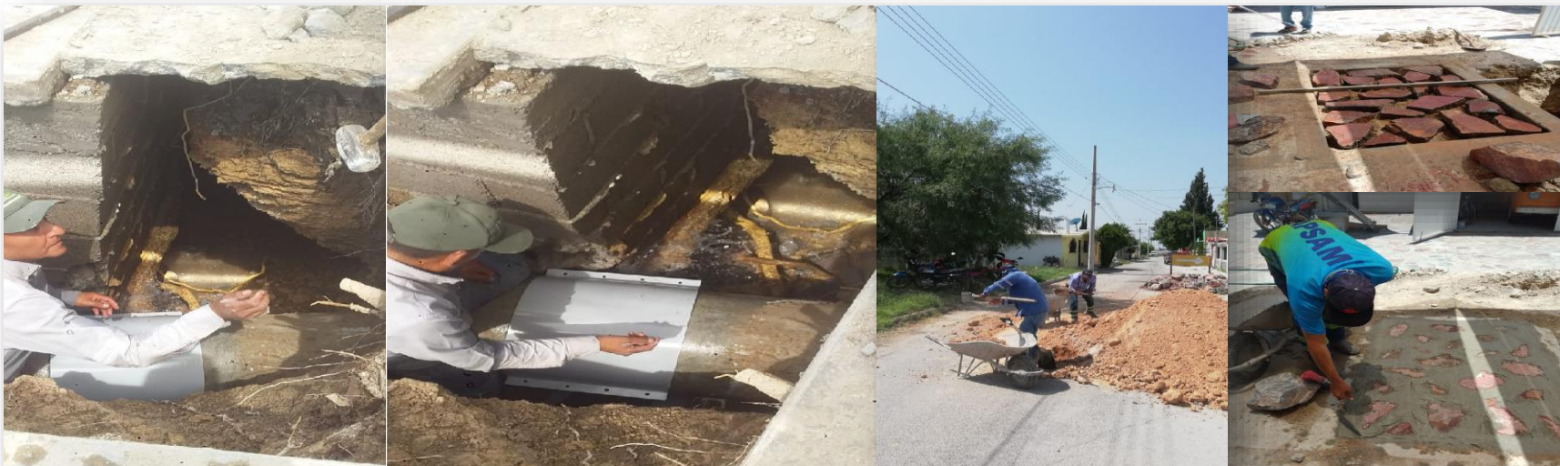
Reparación de fuga en acueducto Cedral- Matehuala en tramo Cedral colonia el Dollar, cambiando abrazadera de lamina P/AC 16" ciega 0.40 cms de ancho
