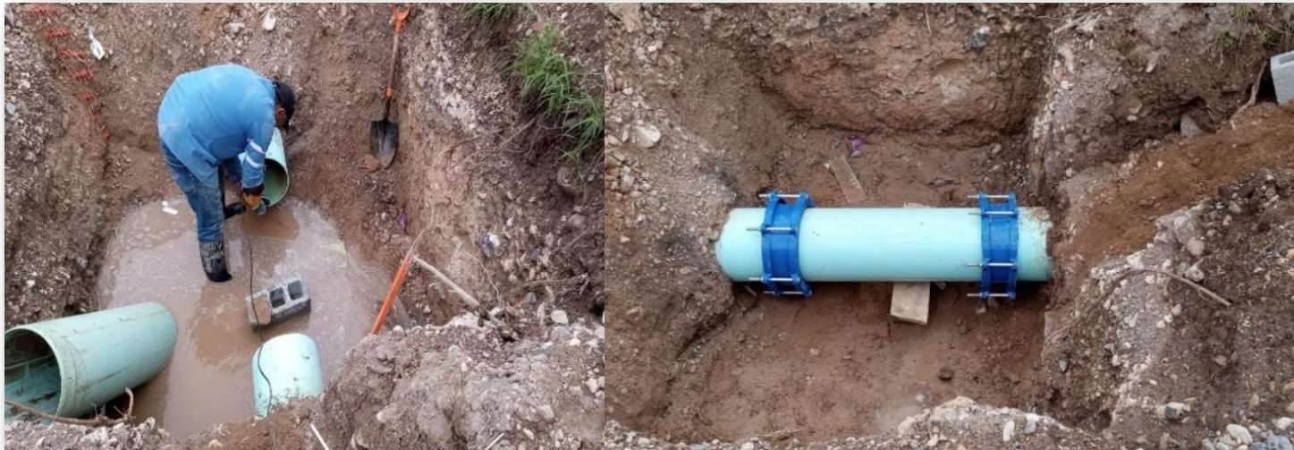
Reparación de fuga en ducto poniente (San Antonio).
