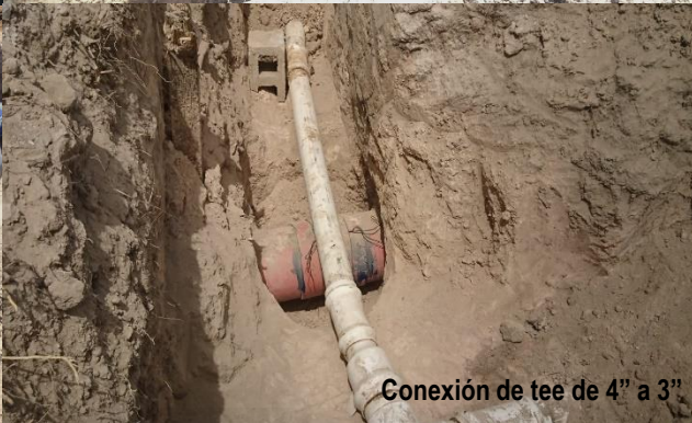
Conexión de tee de 4" a 3"
