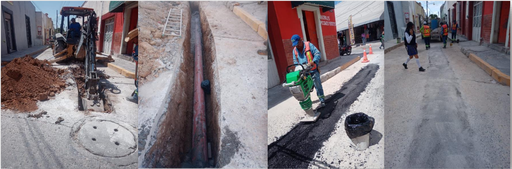
Calle Villanueva entre Bustamante y Ocampo, se rehabilitan 12 ml tubo PVC sanitario de 10"
