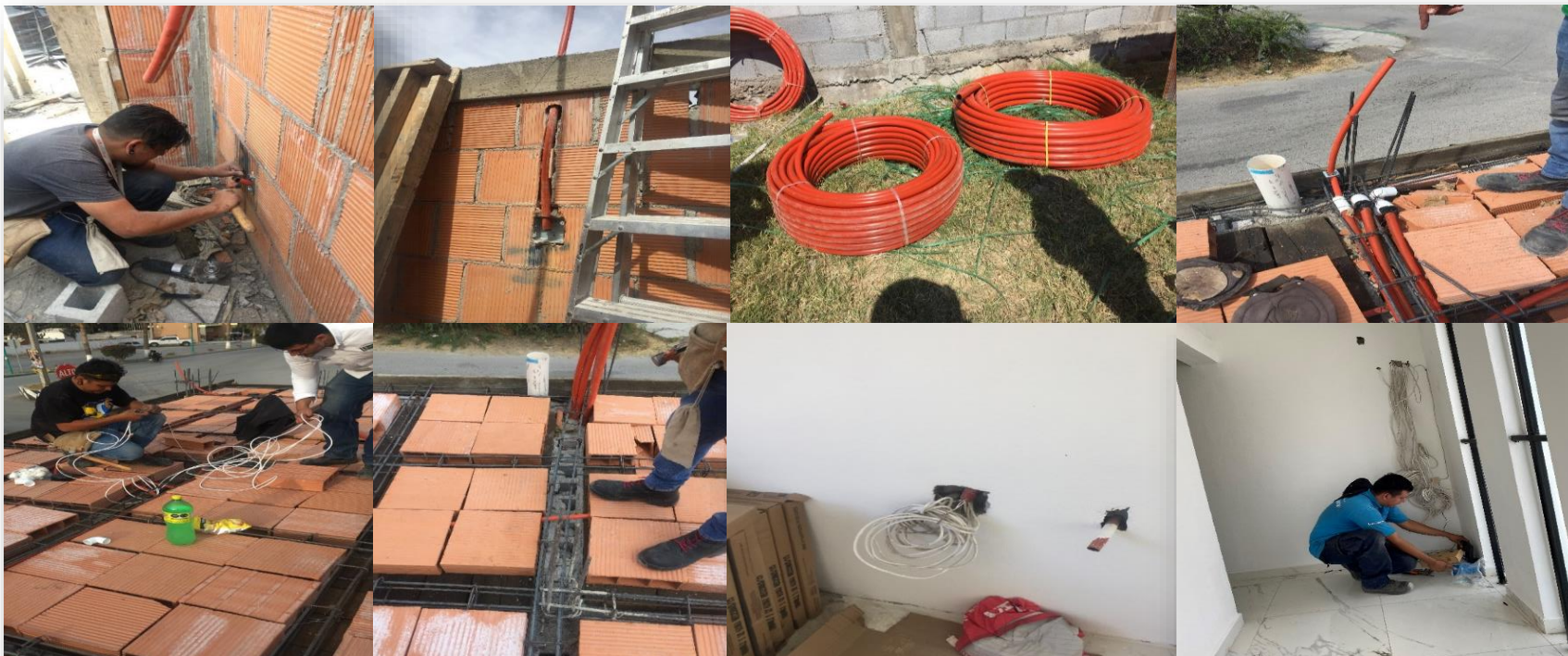
Supervisión de instalación de mangueras para cableado
