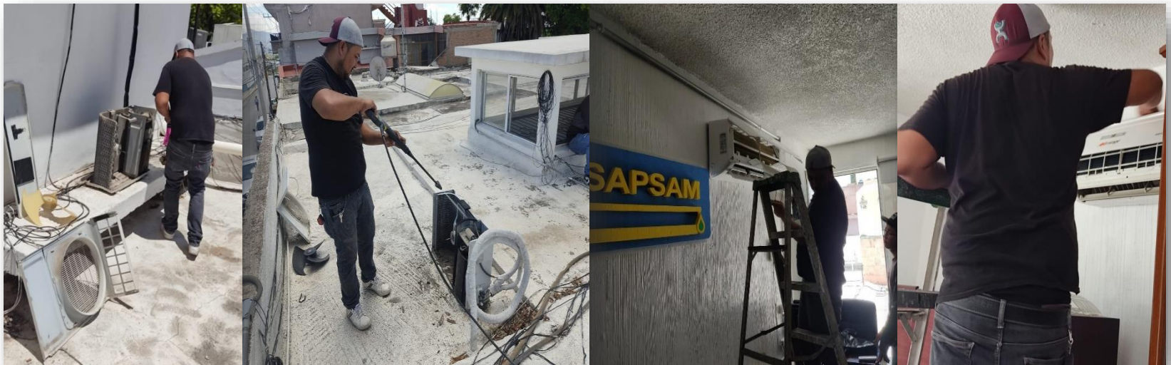
Mantenimiento a aire acondicionado
