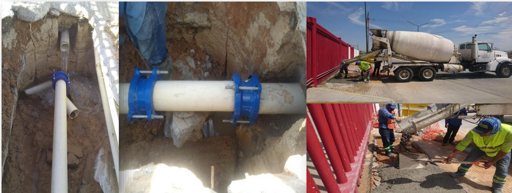
Reparación de fuga en red general Zona Industrial ONE de MX
