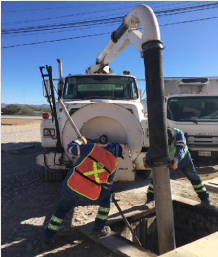
A un costado de la Nissan, se destapan 90 mts y 2 pozos de visita
