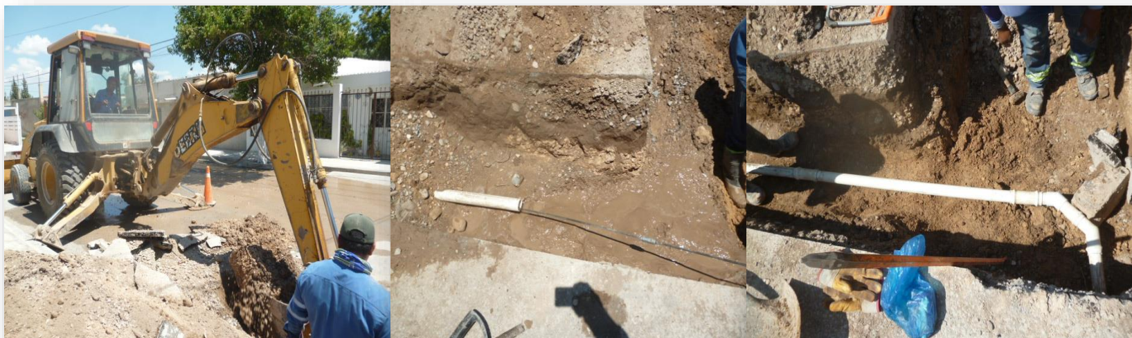
Sondeo en Magisterial Ma. L. Castillo derivado de faltas de agua, se realiza reparación.
