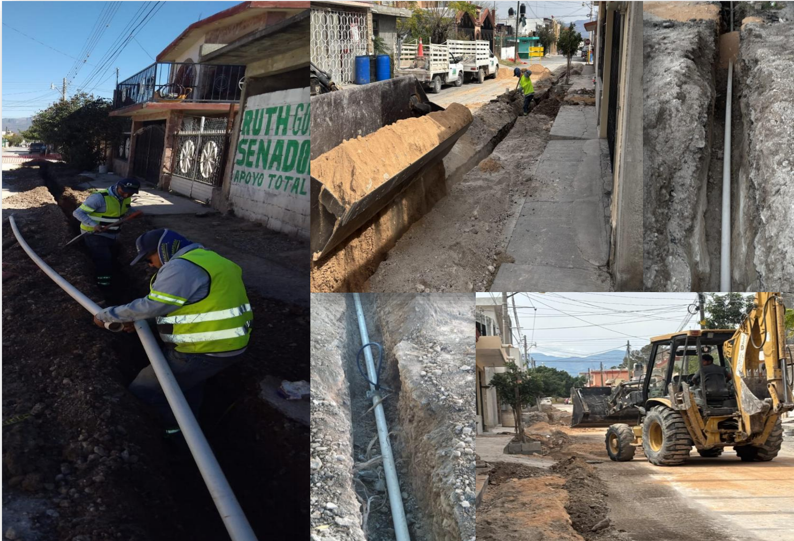
Rehabilitación 210 ml de la red de agua potable, tubería pvc hco. de 2", calle Durango entre Querétaro y Nuevo León, col. República.
