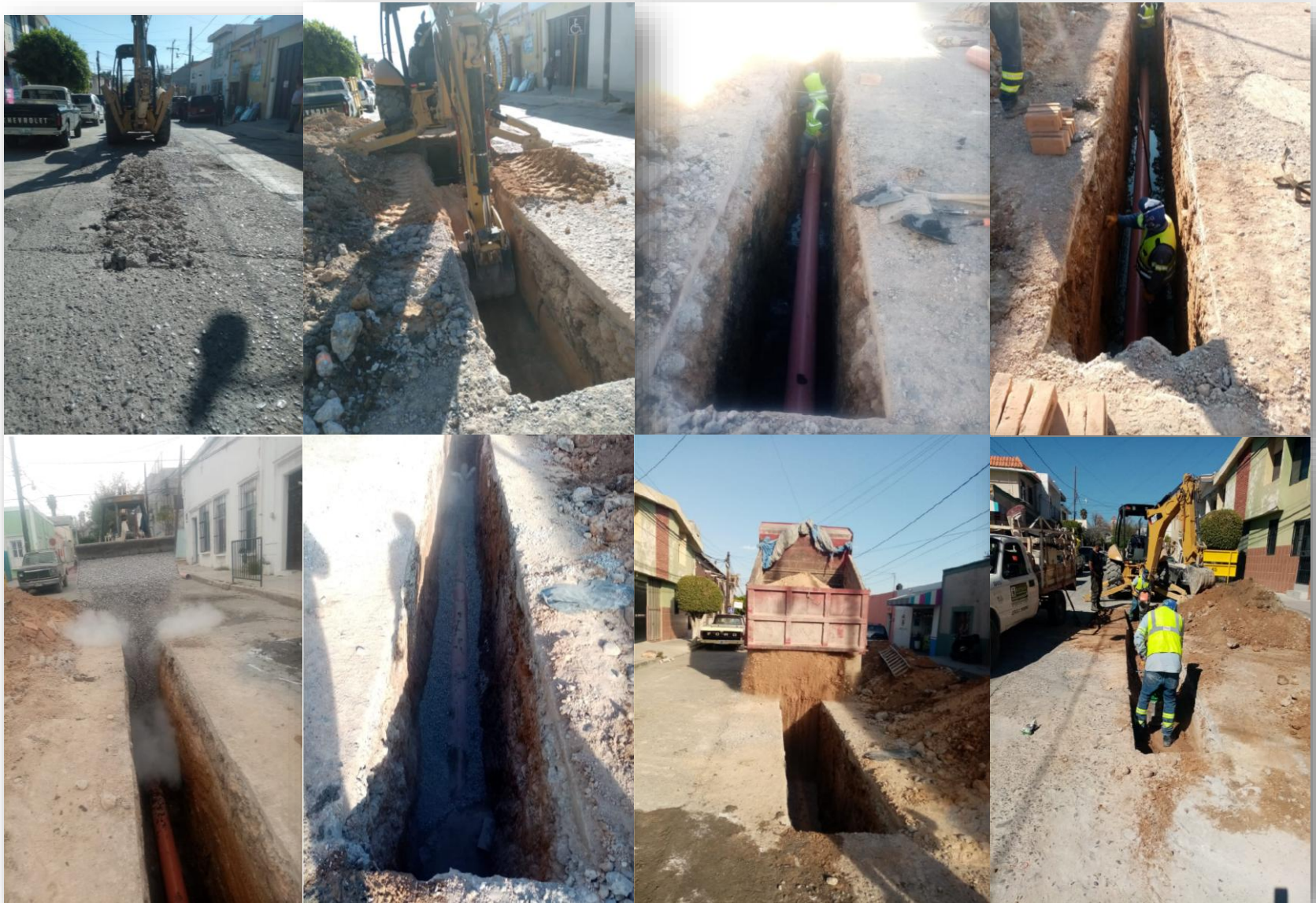
Rehabilitación de 47 ml de la red general de drenaje sanitario, tubo pvc sanitario de 10", calle Julián de los Reyes entre 5 de mayo y 16 de septiembre.
