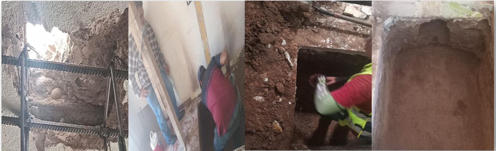
Reparación de vivienda en el domicilio Bustamante 518, por daños derivado de fuga de agua potable
