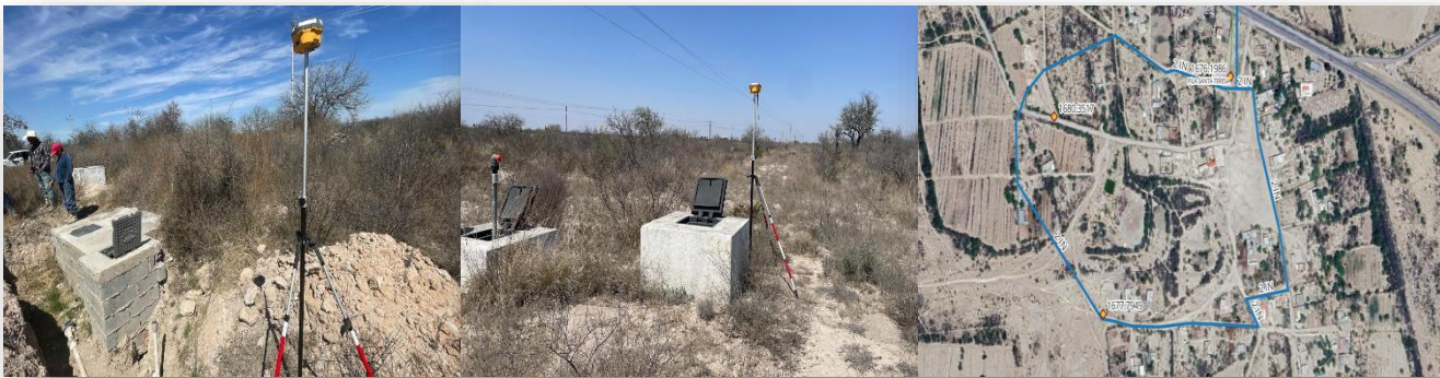
Levantamiento de alturas para cálculo de gasto y presiones para llevar el agua a la comunidad de Santa Teresa
