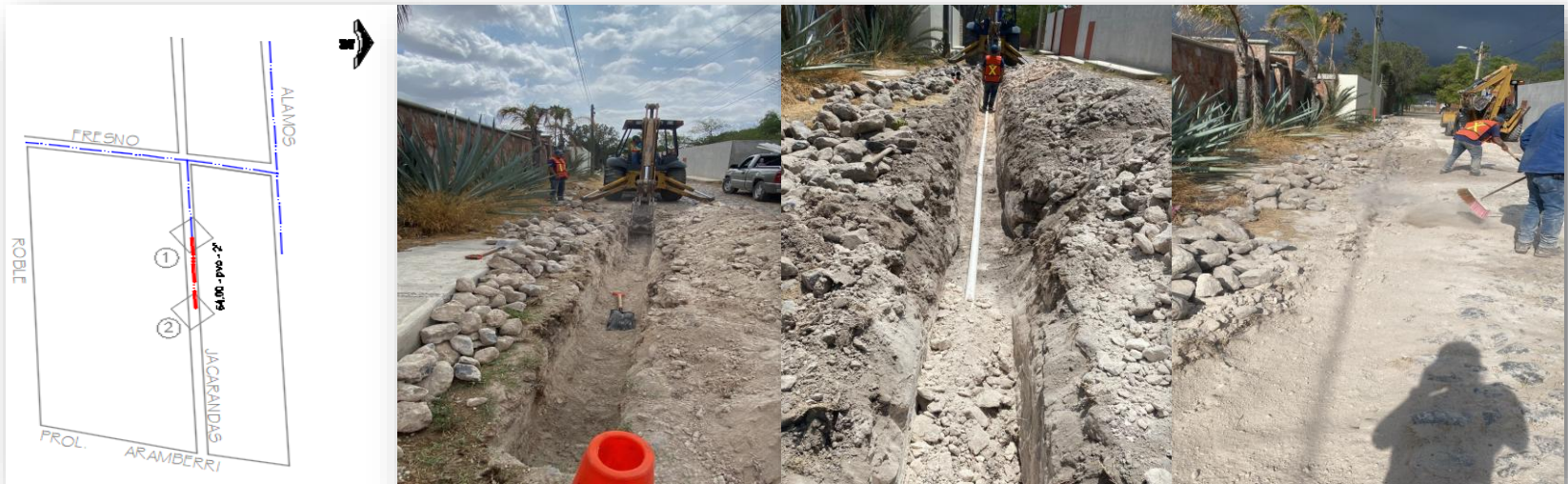
Ampliación de 54 ml de la red de agua potable en la calle Jacarandas entre Fresno y Prol. Aramberri, Col. La Finca, tubería PVC HCO de 2".
