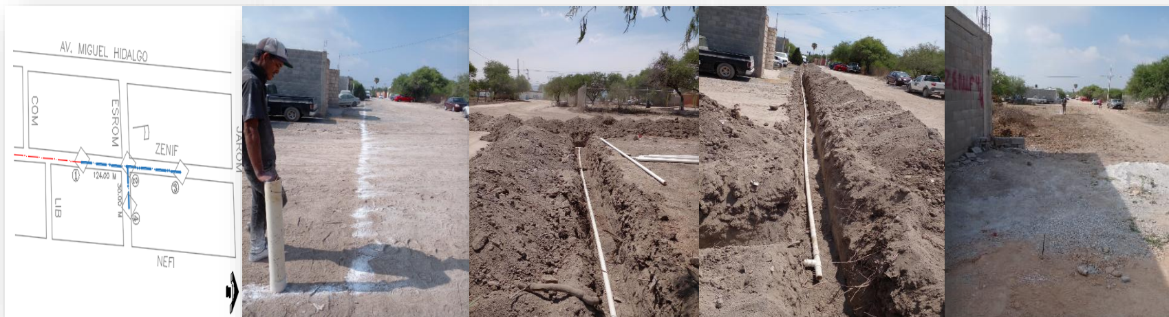
Ampliación de 154 ml de la red de agua potable en la calle Zinfif y Esrom entre Jom y Jarom, Col. La Florida, tubería PVC de 2".
