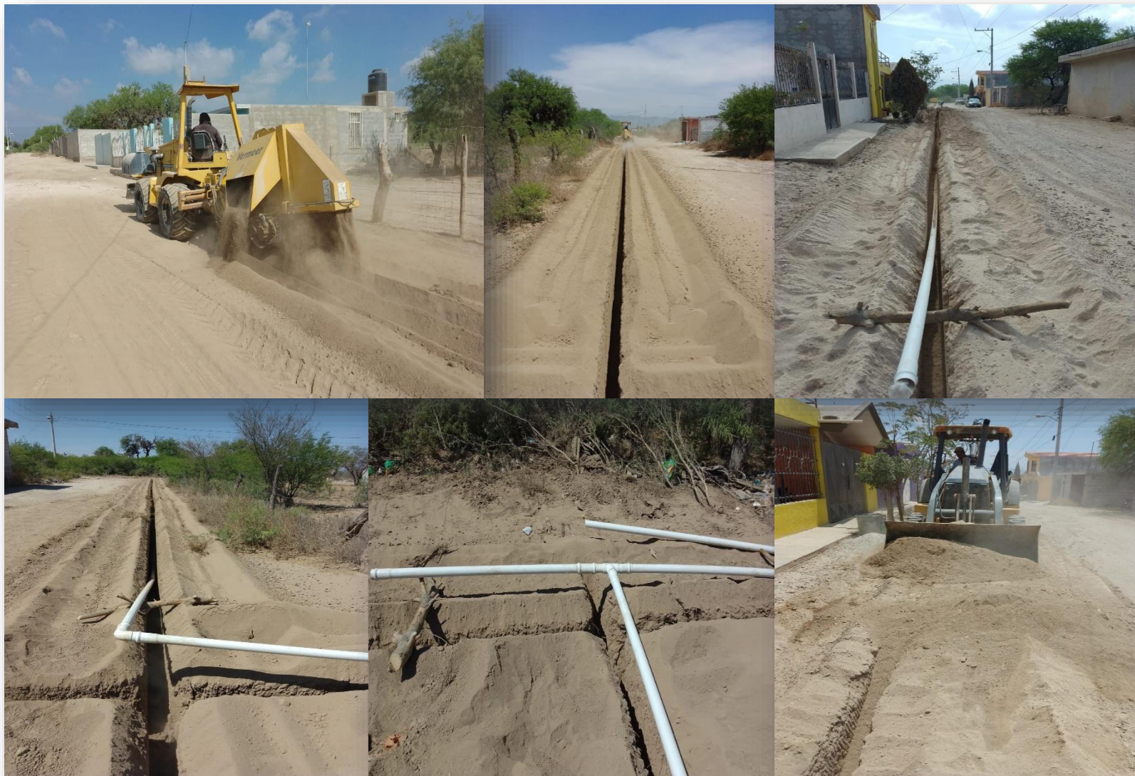
Ampliación de 1,062 ml de la red de agua potable con tubería pvc hca de 2", en fraccionamiento El Ranchito
