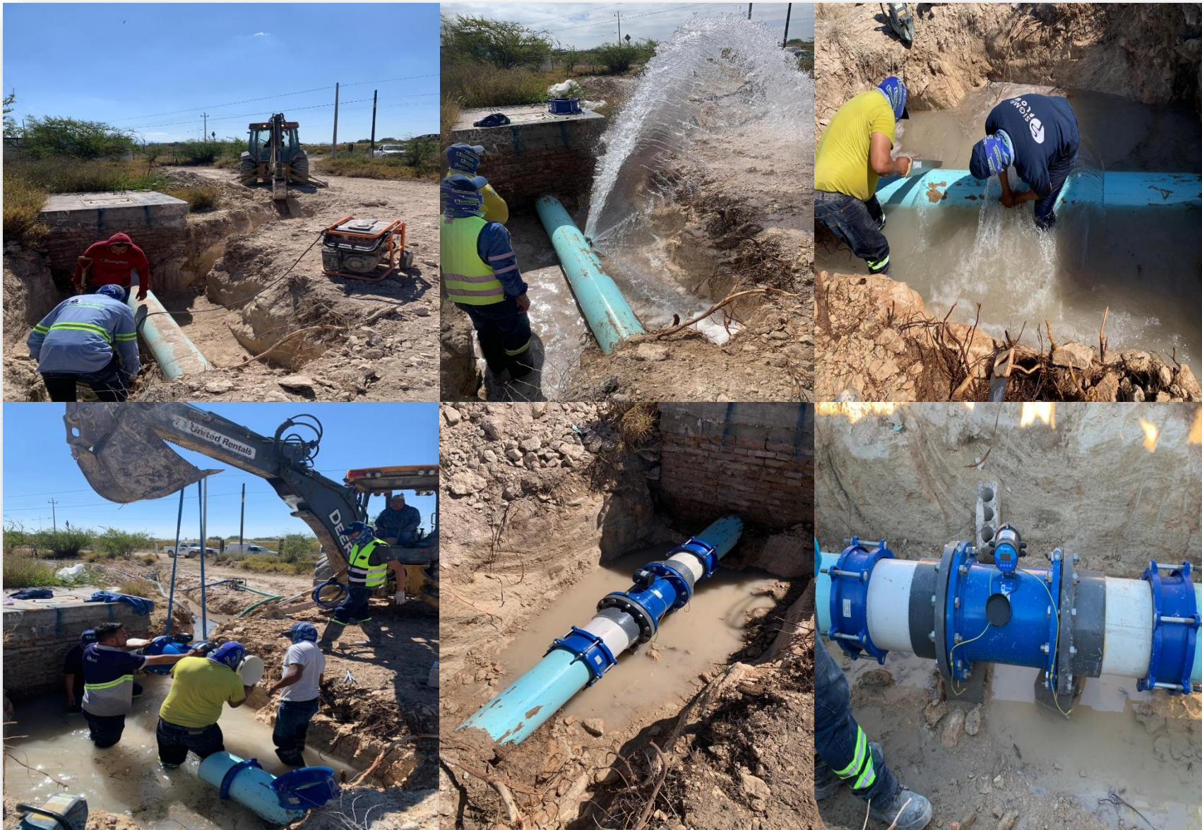
Instalación de macromedidor magnético de 12" en acueducto a la entrada de Tanque Trojes .
