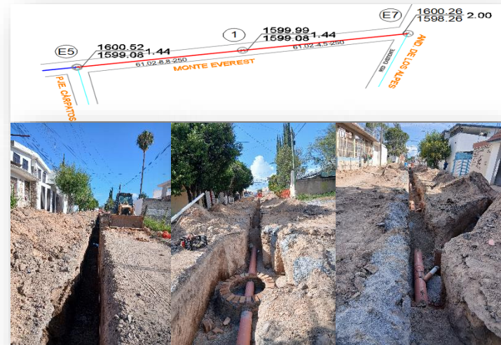
Rehabilitación de 122 ml de la red de drenaje sanitario en Monte Everest, tubería PVC sanitario de 10", un pozo de visita.
