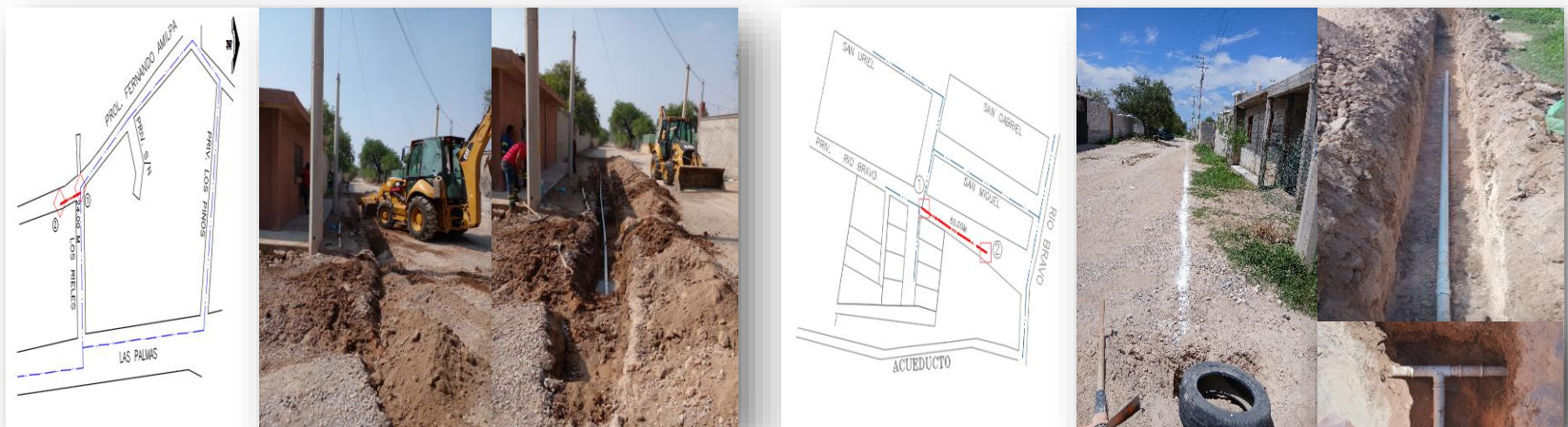
Ampliación de 60 ml de la red de agua potable en Priv. Río Bravo, Col. Las Animas, tubería PVC HCO de 2".
