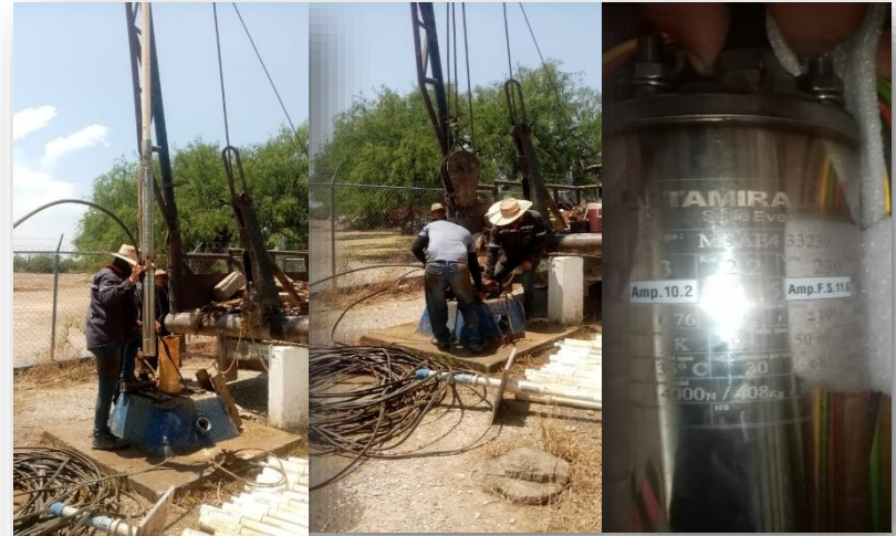
Motor sumergible de 5 hp, Pozo Noria de los Castillo
