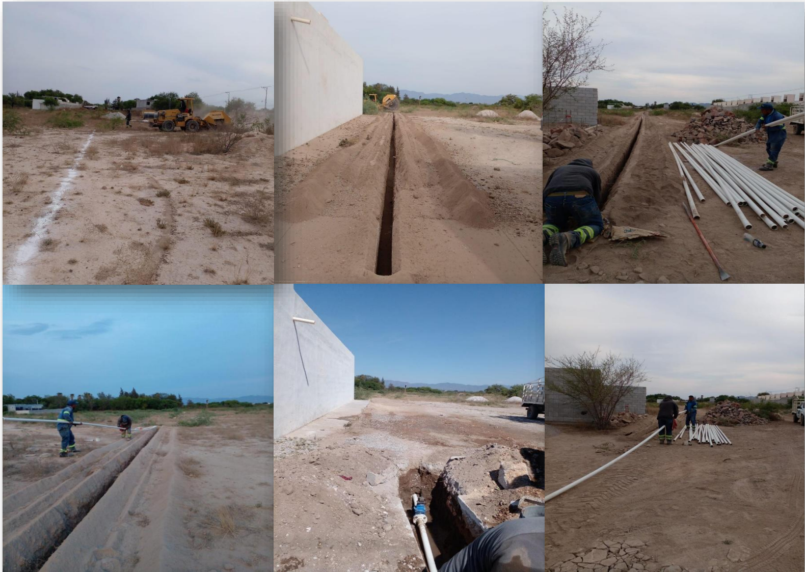
Ampliación de 168 ml de la red de agua potable con tubería pvc hca. de 2", en calle Valle de los Pinos, fraccionamiento Valle de las Brisas.
