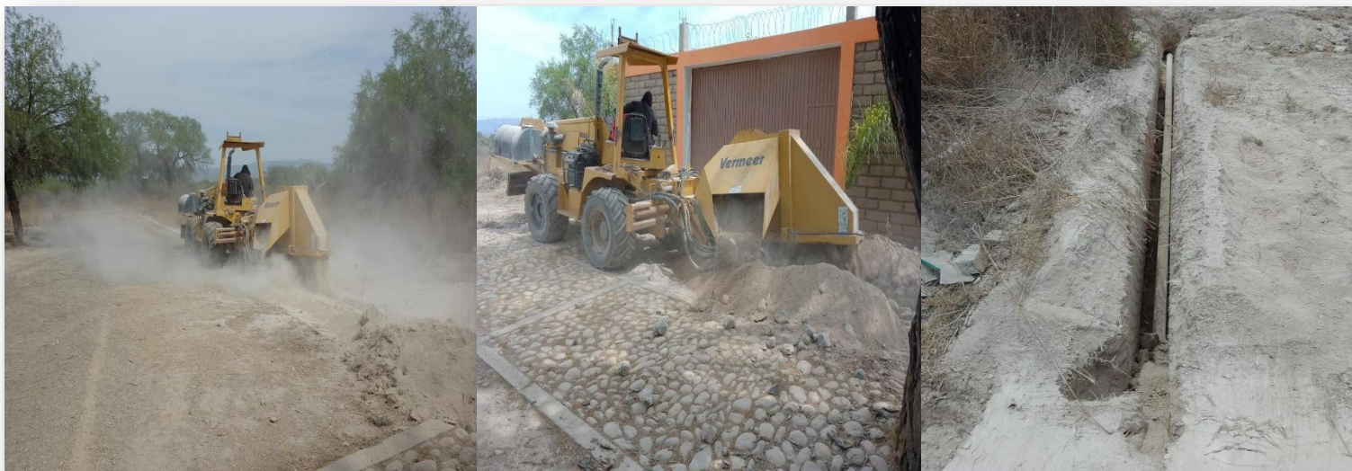
Ampliación de 156 ml de la red de agua potable con tubería de 2" en fraccionamiento Hacienda Santa Martha
