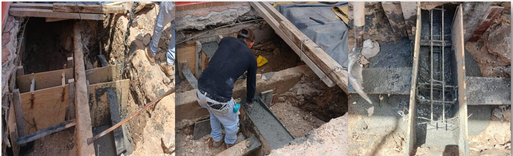
Apoyo a reparación de socavón de 4 mts de profundidad en Priv. Reforma no. 108
