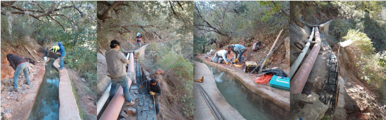
Reparación de 12 ml de pared de canal de mampostería tramo denominado el paso del diablo
