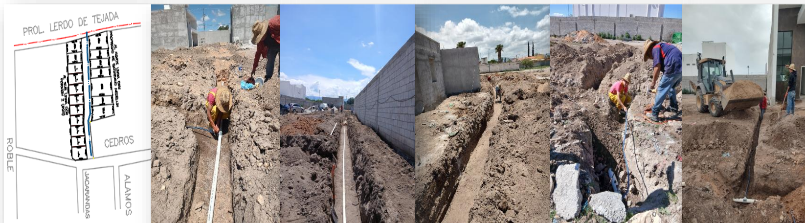
Ampliación de 110 ml de la red de agua potable en Privada Cedros, Col. La Finca, tubería PVC HCO de 2" y 18 tomas domiciliarias.
