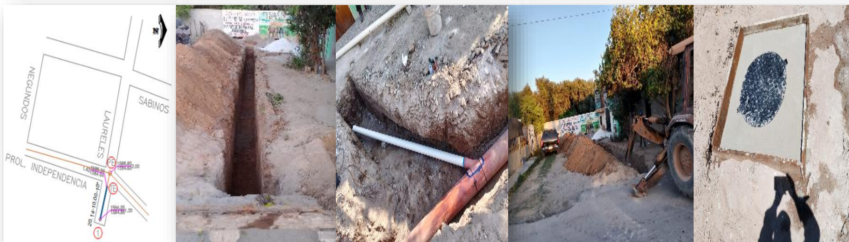
Ampliación de 20 ml de la red de drenaje sanitario en la calle Laureles entre Independencia y propiedad privada Col. Olivar, tubería PVC sanitario de 10" y construcción de 1 pozo de visita.
