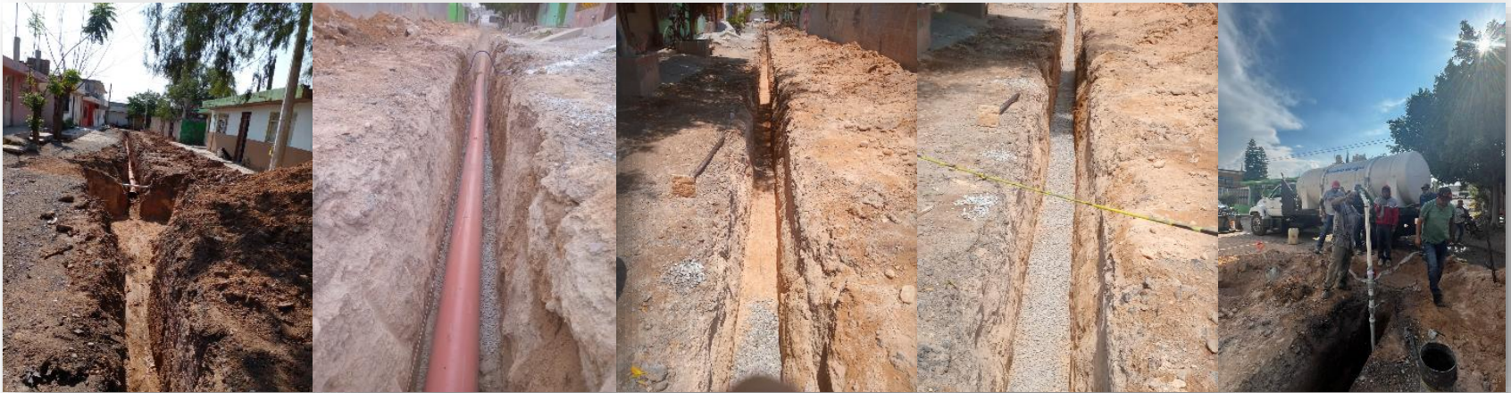
Rehabilitación de 157.96 ml de la red de drenaje sanitario en la calle Dalia entre Independencia y Prol. Libertad, Col. Olivar, tubería PVC Sanitario de 10".
