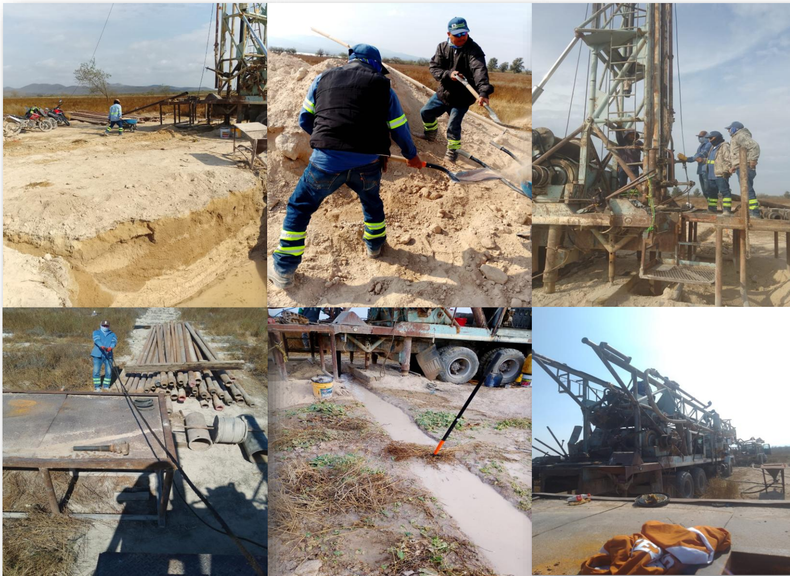
Perforación pozo nuevo en rancho Santa Martha buscando nueva fuente de abastecimiento
