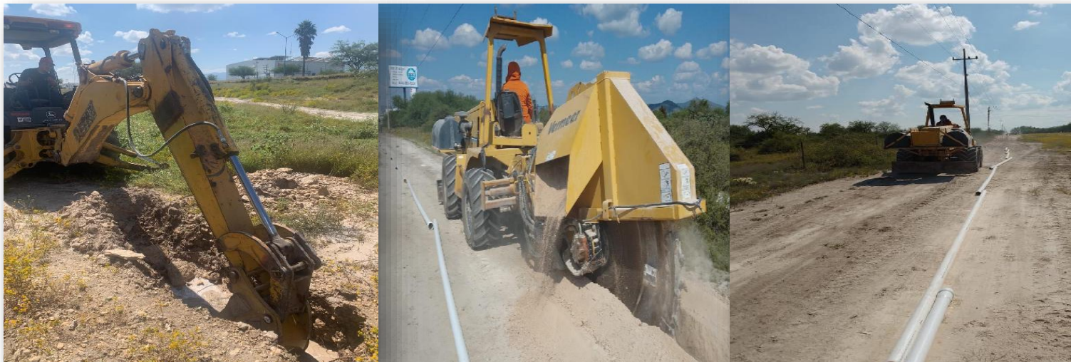
Ampliación de 1,434 ml de la red de agua potable con tubería de 3" en lateral de la carretera 57, al norte
