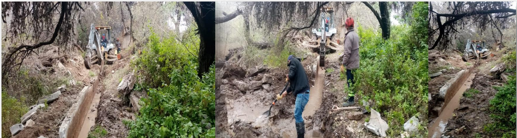
Rehabilitación de 117 ml de canal de mampostería y tubería pvc hco. De 8”, tramo San Vicente
