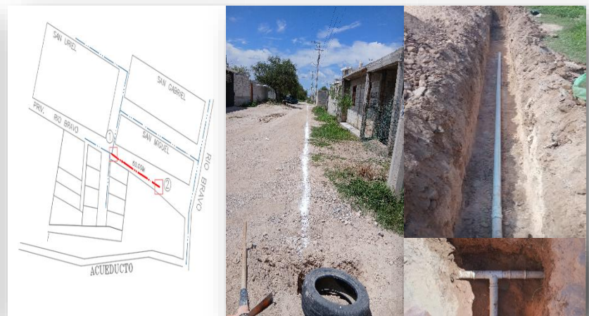
Ampliación de 60 ml de la red de agua potable en Priv. Río Bravo, Col. Las Animas, tubería PVC HCO de 2".
