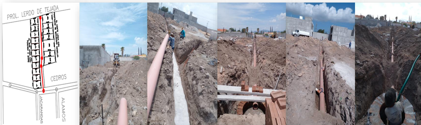
Ampliación de 117.46 ml de la red de drenaje sanitario en Privada Cedros, Col. La Finca, tubería PVC sanitario de 10" y 4 pozos de visita.
