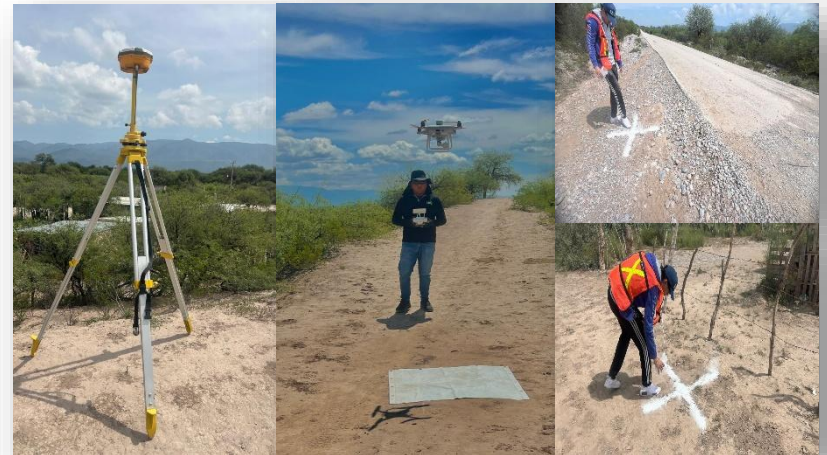
Levantamiento topográfico para proyecto en San José de los Guajes
