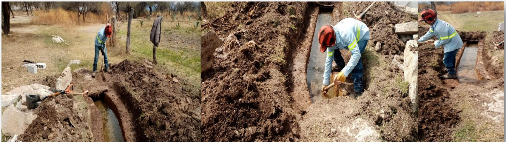
Rehabilitación de 27.5 ml de canal de mampostería, tramo Chilares a Tanque Colorado.
