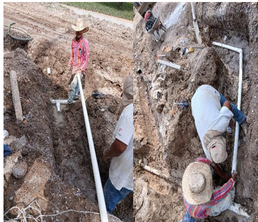
Ampliación de 60 ml de la red de agua potable en Av. Las Américas, tubería PVC HCO de 2".
