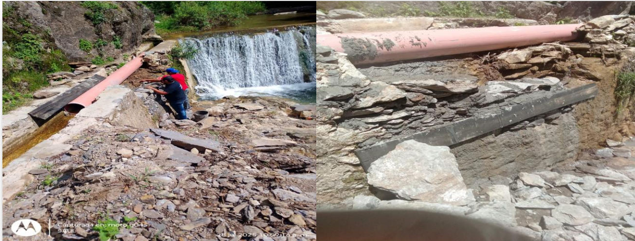
Rehabilitación de 6 ml de canal
