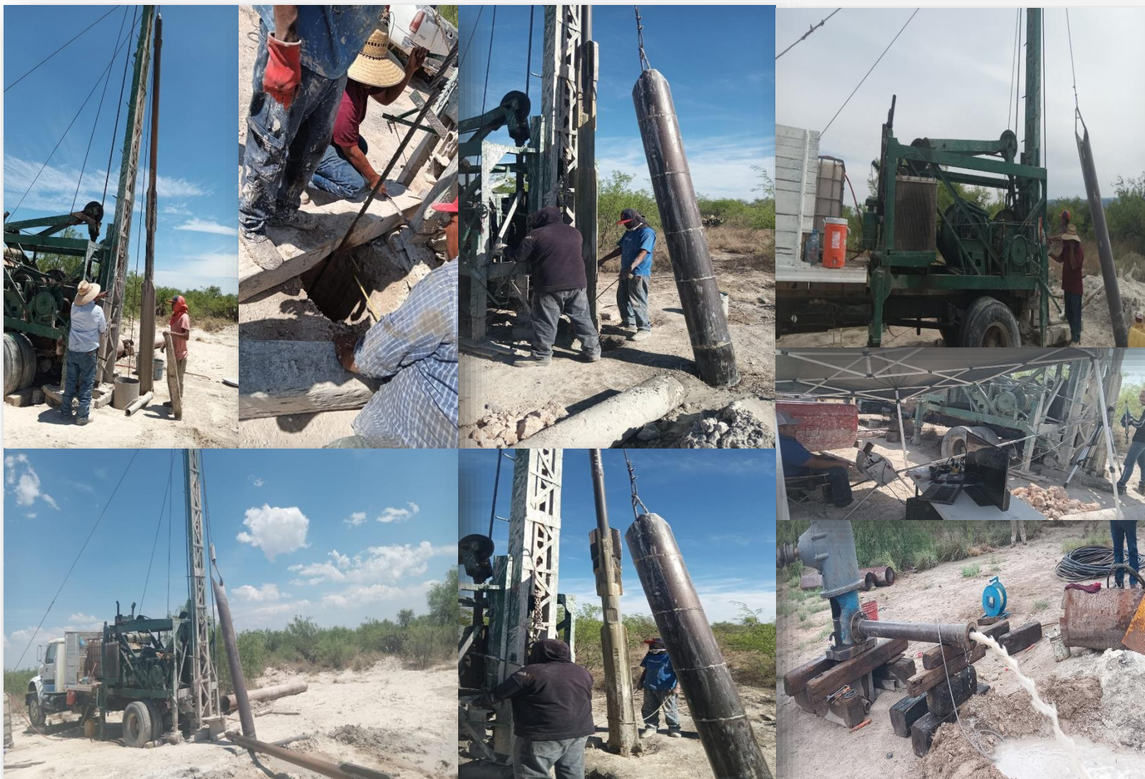
Perforación de pozo profundo para reposición de pozo existente para abastecimiento de agua potable a la ciudad de Matehuala. Contrato SAPSAM-AD-OB-004-2025.
