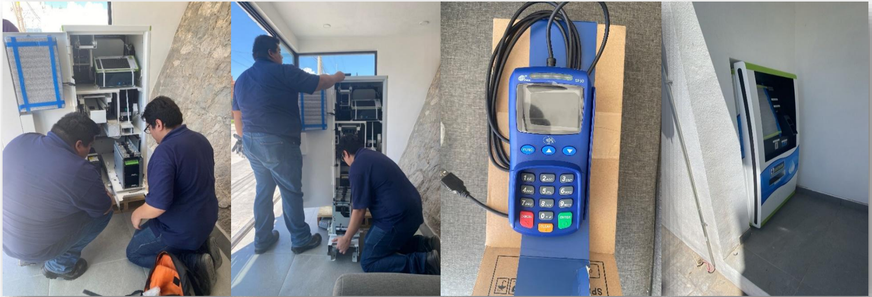
Instalación de cajero automático en oficinas nuevas Bustamante
